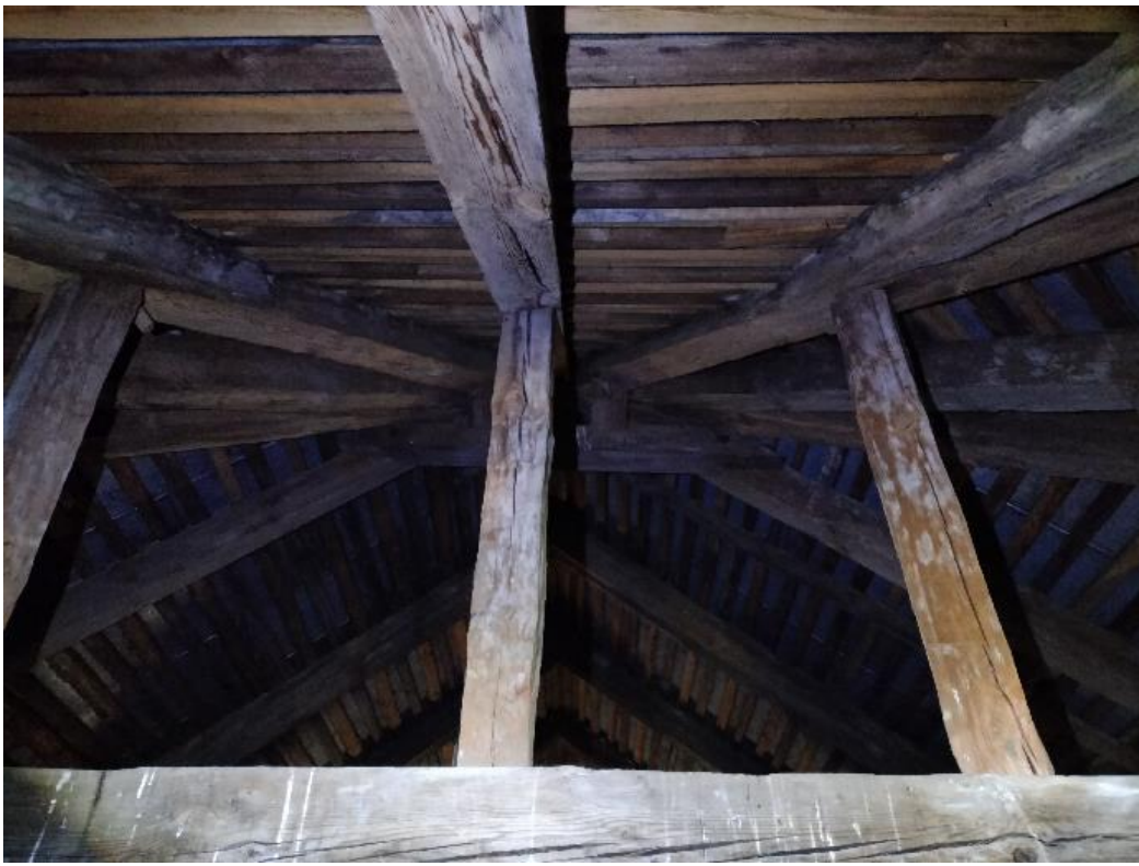
Fot. 7. Skorodowane elementy więźby dachowej
