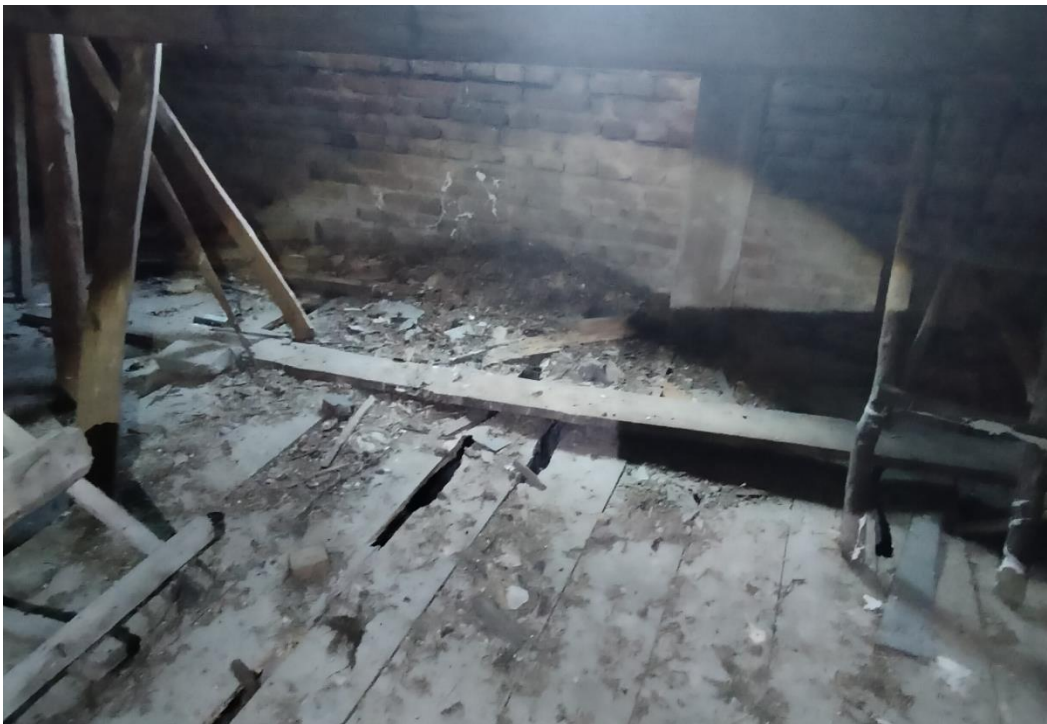
Fot. 3. Uszkodzone deskowanie stropu
