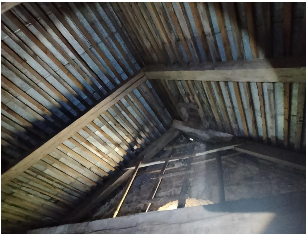
Fot. 4. Deskowanie więźby dachowej
