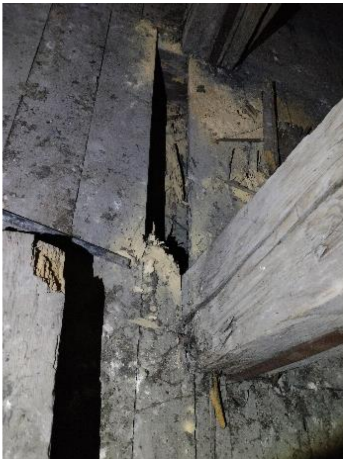
Fot. 2. Uszkodzone deskowanie stropu
