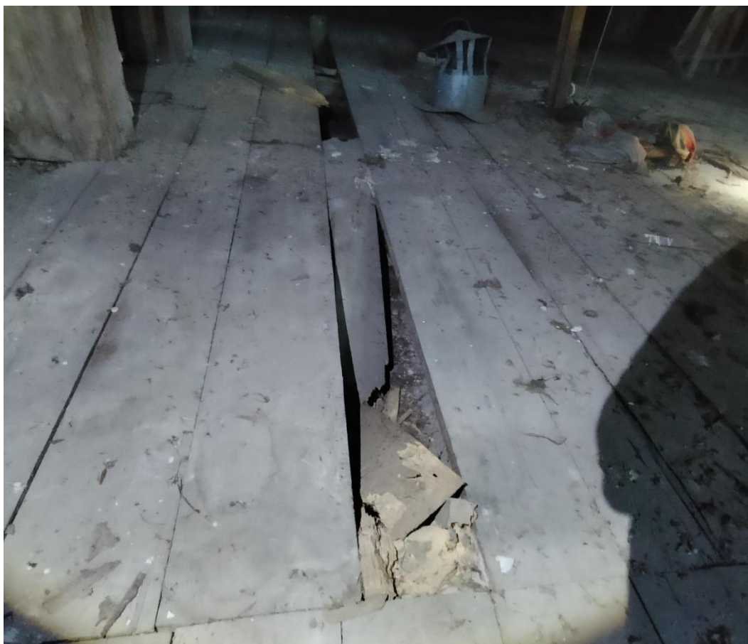
Fot. 1. Uszkodzone deskowanie stropu
