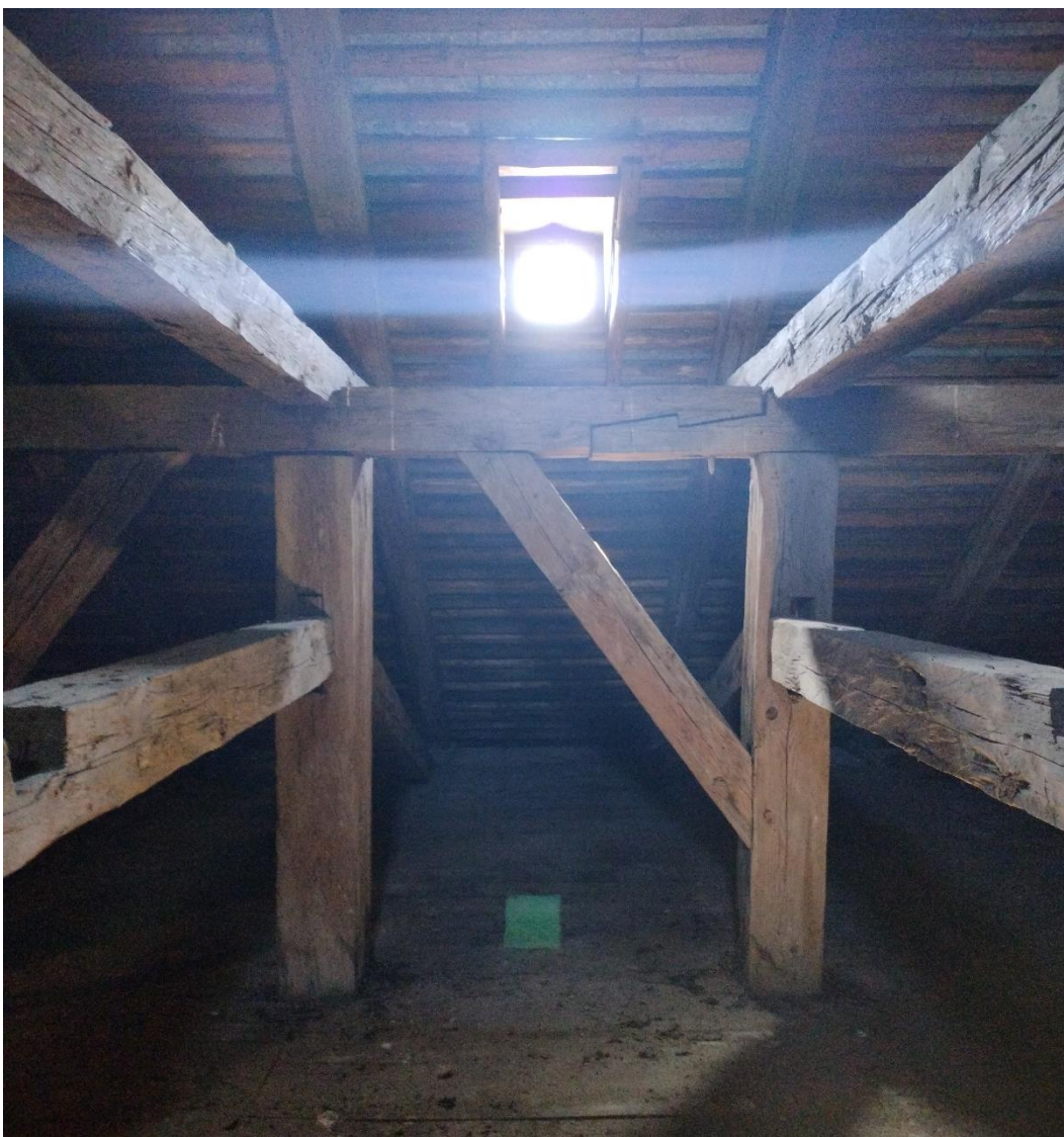
Fot. 6. Elementy więźby dachowej z okienkiem doświetlającym
